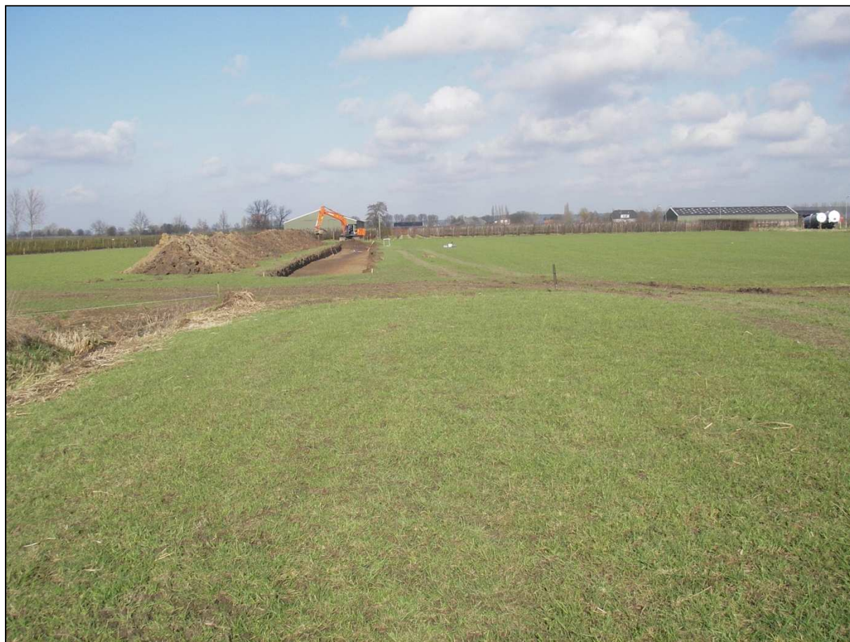
Afbeelding 1: Aanleg van werkput 2 vanuit het zuiden gezien.
